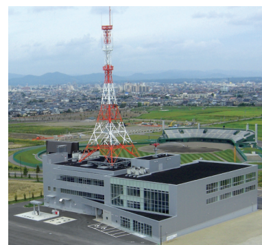
総合防災センター中核施設
